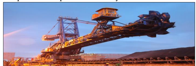
Fig.3: Stacker cum reclaimer
