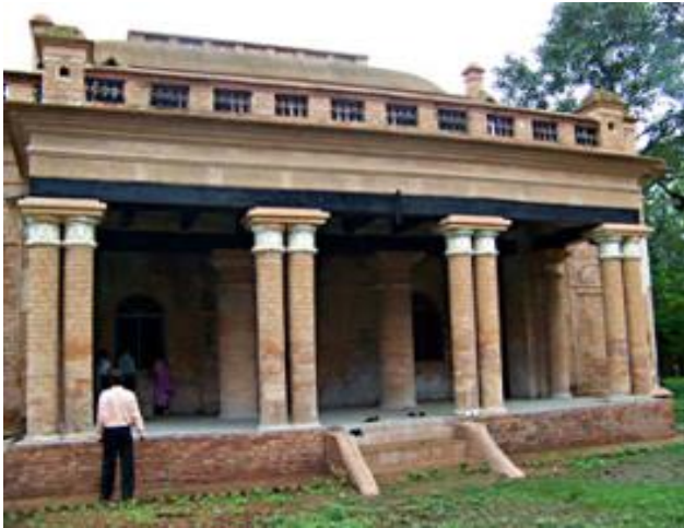
(d) Masonry construction
