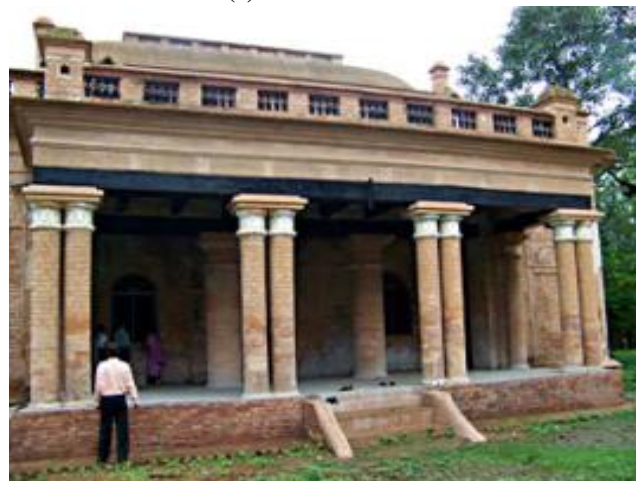
(d) Masonry construction
